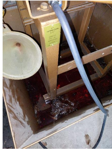
Rétention cuve 500 L aérienne – produit pur dans la rétention
