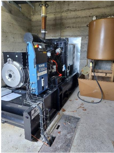
Groupe électrogène et cuve aérienne 500 L fioul
